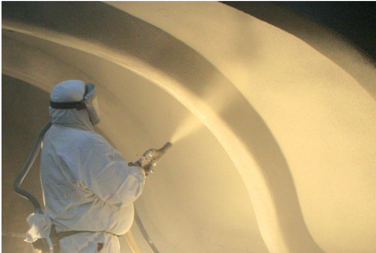
a) Feinbeton auftragen
